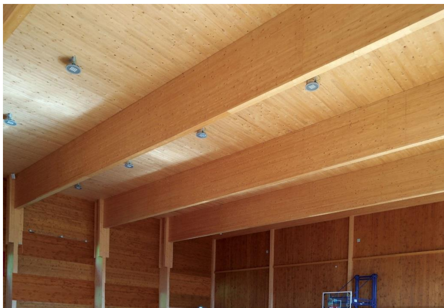
Particolare travature in legno
